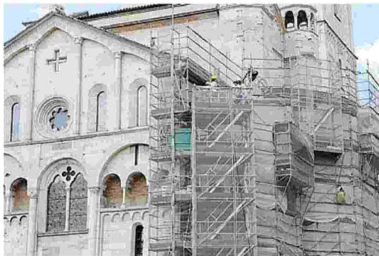
Il complesso Duomo-Ghirlandina con l'abside ancora occupato dai lavori di restauro
